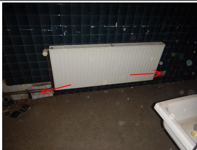
123 : Ventilation basse en fibres-ciment L014 - PRE:PP073
