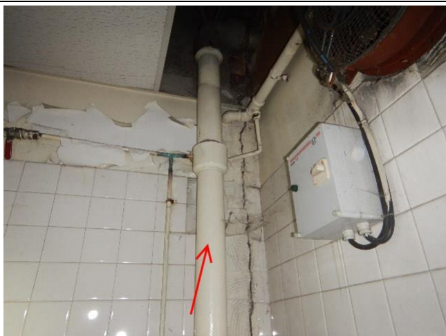
122 : Conduits en fibres-ciment L014 - PRE:PP072
