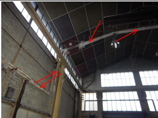
079 : Calorifugeage tuyauterie avec Enveloppe L013 - PRE:PP052
