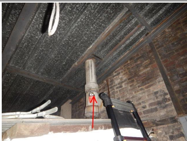
074 : Conduits en fibres-ciment vers L021 et toiture L022 - PRE:PP047
