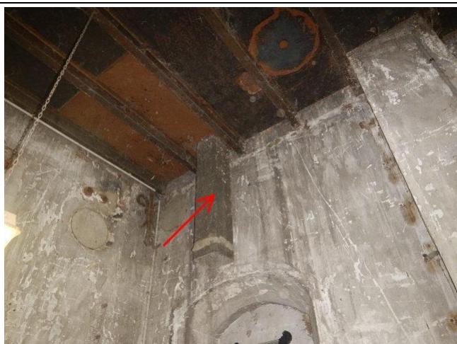
068 : Conduits en fibres-ciment L011 - PRE:PP041
