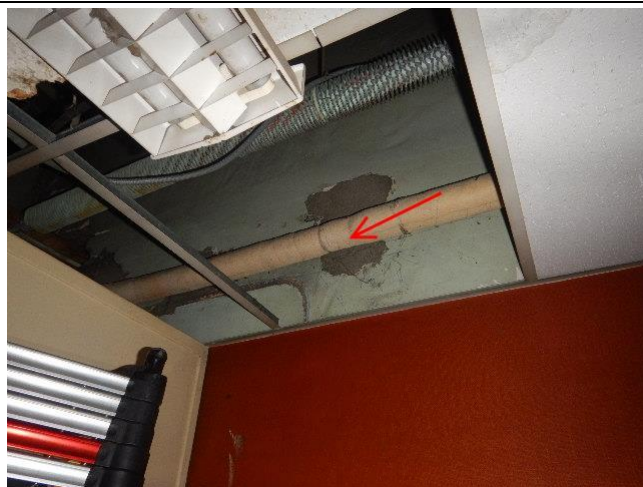
112 : Calorifugeage tuyauterie avec Enveloppe L015 - PRE:PP065
