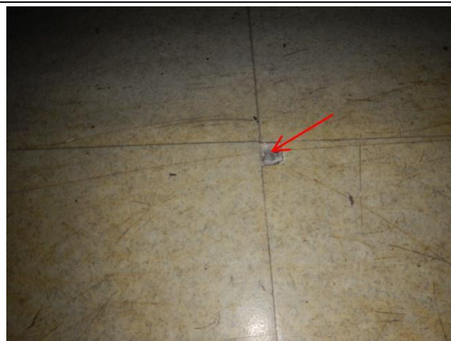
101 : Dalle de sol rigide + colle noire + ragréage en partie inférieure L017 - PRE:PP060
